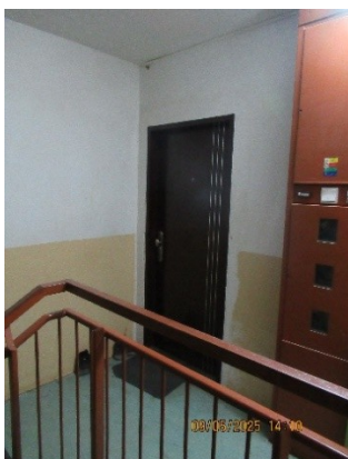
Vstup do bytu č. 8
