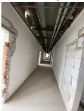
Interiér hlavná budova súp. č. 2978 – 2.NP
