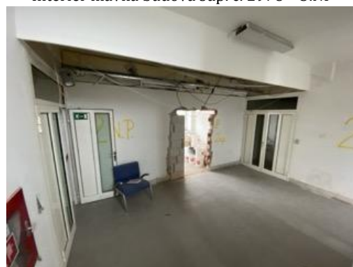
Interiér hlavná budova súp. č. 2978 – 2.NP
