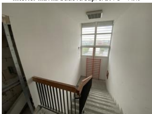
Interiér hlavná budova súp. č. 2978 – 7.NP
