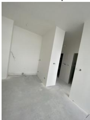
Interiér hlavná budova súp. č. 2978 – 5.NP
