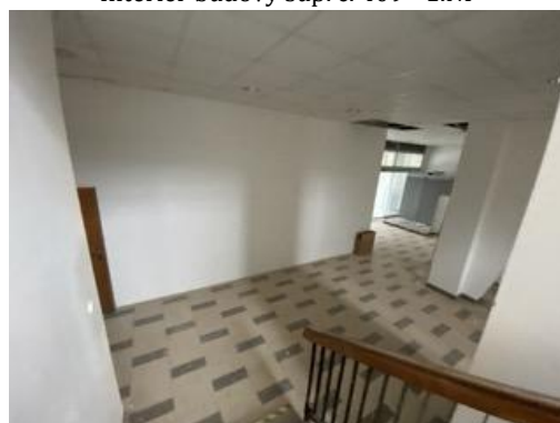
Interiér hlavná budova súp. č. 2978 – 1.NP
