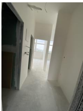
Interiér hlavná budova súp. č. 2978 – 5.NP
