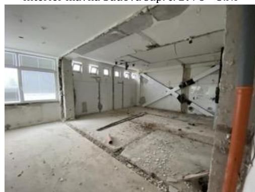
Interiér hlavná budova súp. č. 2978 – 3.NP
