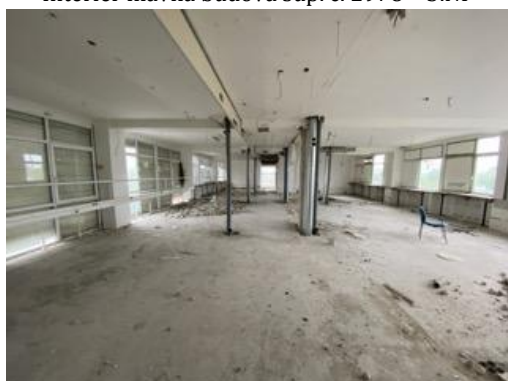
Interiér hlavná budova súp. č. 2978 – 3.NP
