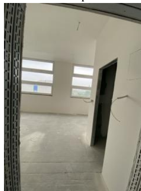
Interiér hlavná budova súp. č. 2978 – 5.NP
