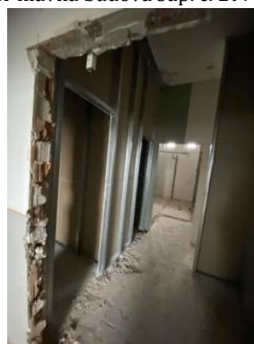
Interiér hlavná budova súp. č. 2978 – 5.NP
