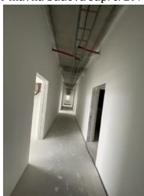
Interiér hlavná budova súp. č. 2978 – 5.NP
