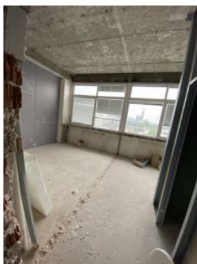
Interiér hlavná budova súp. č. 2978 – 5.NP
