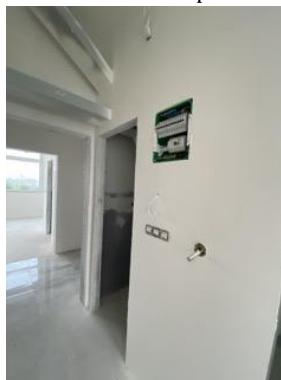
Interiér hlavná budova súp. č. 2978 – 6.NP
