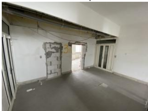
Interiér hlavná budova súp. č. 2978 – 3.NP
