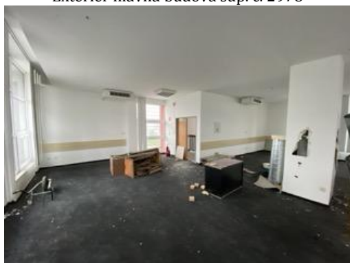
Interiér hlavná budova súp. č. 2978 – 7.NP
