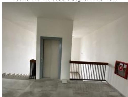
Interiér hlavná budova súp. č. 2978 – 6.NP
