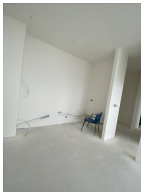
Interiér hlavná budova súp. č. 2978 – 6.NP
