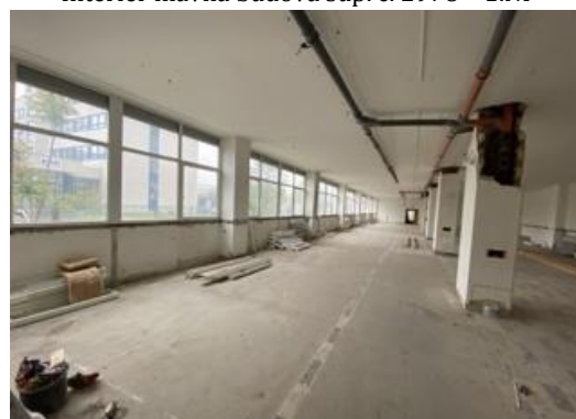
Interiér hlavná budova súp. č. 2978 – 1.NP
