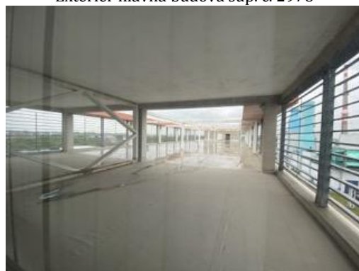
Interiér hlavná budova súp. č. 2978 – 7.NP
