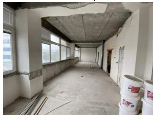
Interiér hlavná budova súp. č. 2978 – 3.NP
