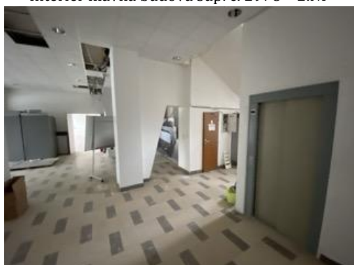
Interiér hlavná budova súp. č. 2978 – 1.NP
