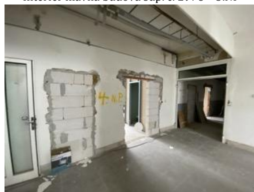
Interiér hlavná budova súp. č. 2978 – 5.NP
