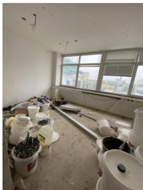
Interiér hlavná budova súp. č. 2978 – 2.NP
