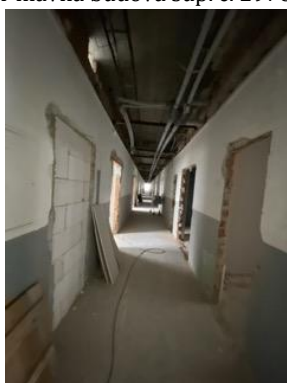
Interiér hlavná budova súp. č. 2978 – 5.NP
