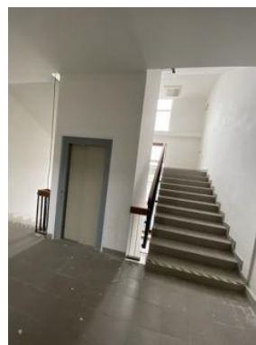
Interiér hlavná budova súp. č. 2978 – 5.NP
