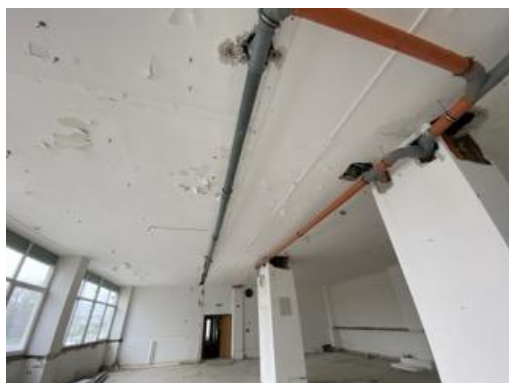
Interiér hlavná budova súp. č. 2978 – 1.NP
