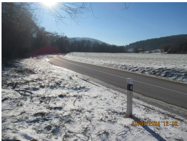
parc. E-KN č. 969/1 k.ú. Andrejová (severný pohľad)
