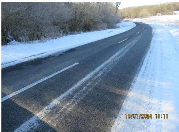
parc. E-KN č. 489/1 k.ú. Andrejová) (severný pohľad)
