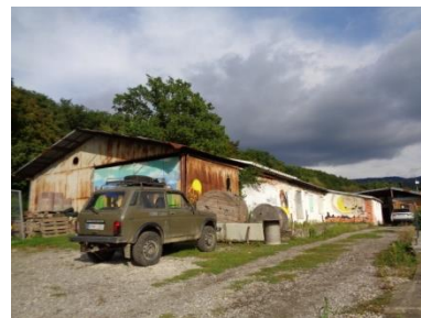
maštal' č.s. 423 evidovaná na LV č. 1154 k.ú. Kálnica
