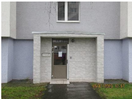
Vchod č. 33 (severná strana)
