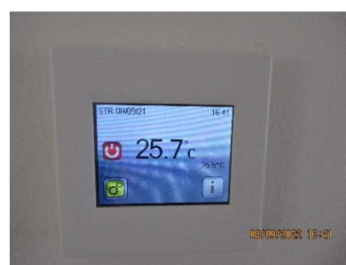
Regulácia podlahového vykurovania
