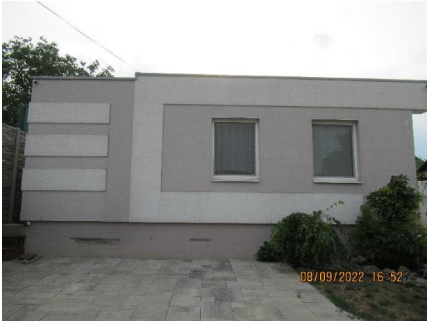
Rodinný dom s.č. 1591 na pozemku parc. č. 5150/2 k.ú. Krásna (čelný pohľad / východná strana)
