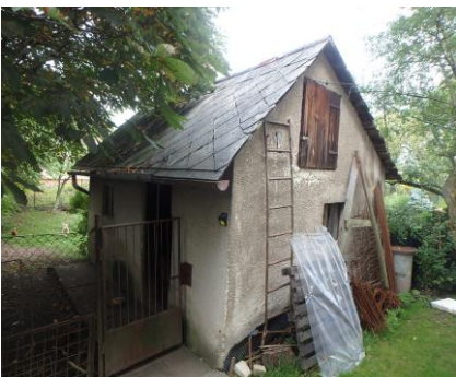
Drobná stavba – chov hydiny
