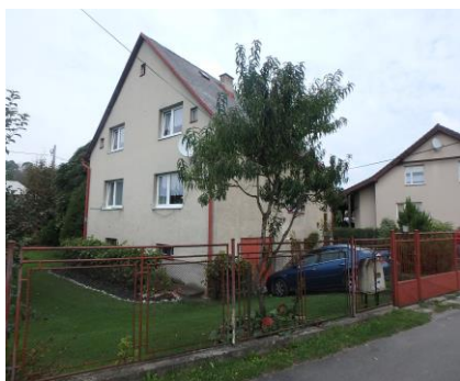
RD č. s. 816 – pohľad z ulice - J
