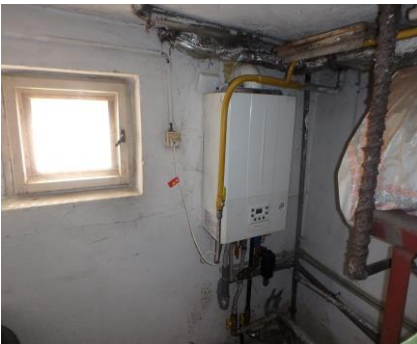
Nástenný plynový kotol ÚK v I. PP
