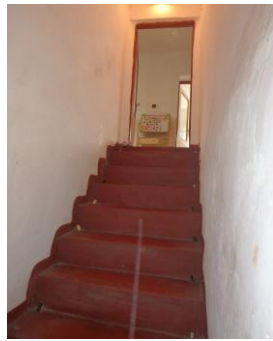
Schodište z I. NP do suterénu
