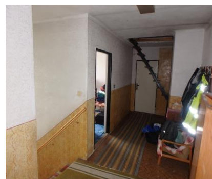
Chodba v podkroví s oceľovým schodišťom do povalového priestoru
