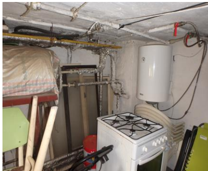
El. bojler na prípravu TUV v I. PP
