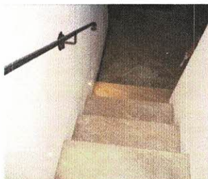
1.PP: vstupné schody
