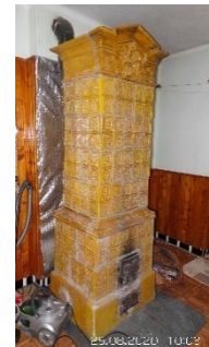
Lokálny zdroj tepla
