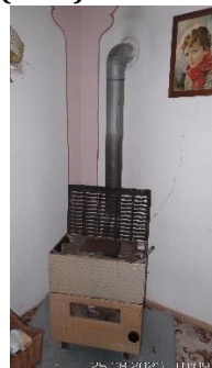
Lokálny zdroj tepla
