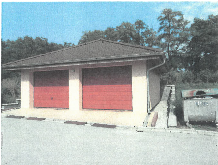
Garáž na parc. č. 1288/107, k.ú. Malženice
