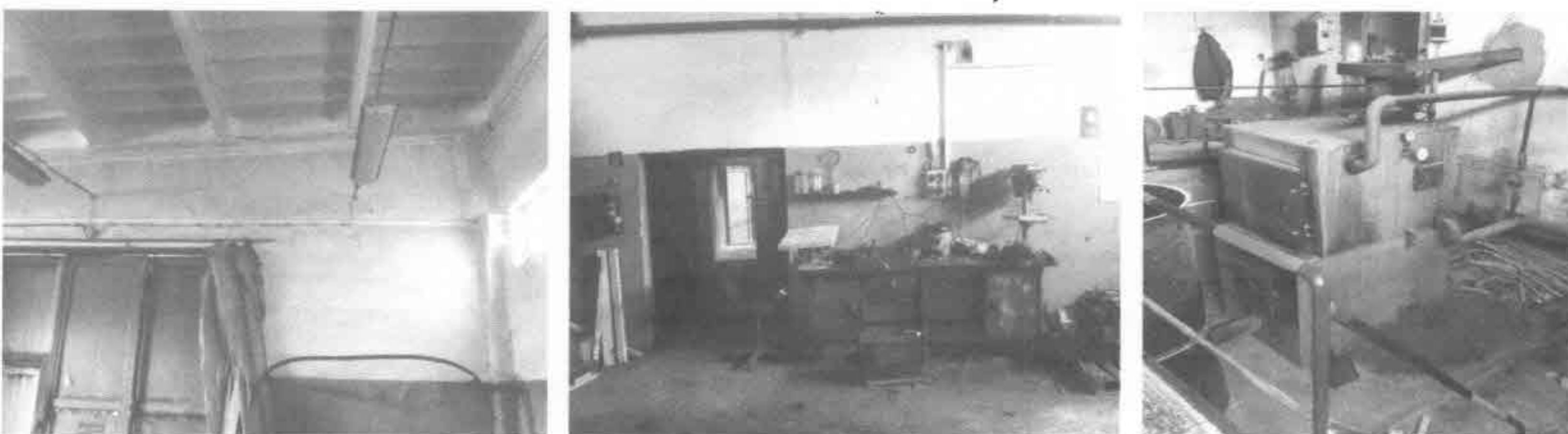
Budova energobloku na parc. č. 1405/4
