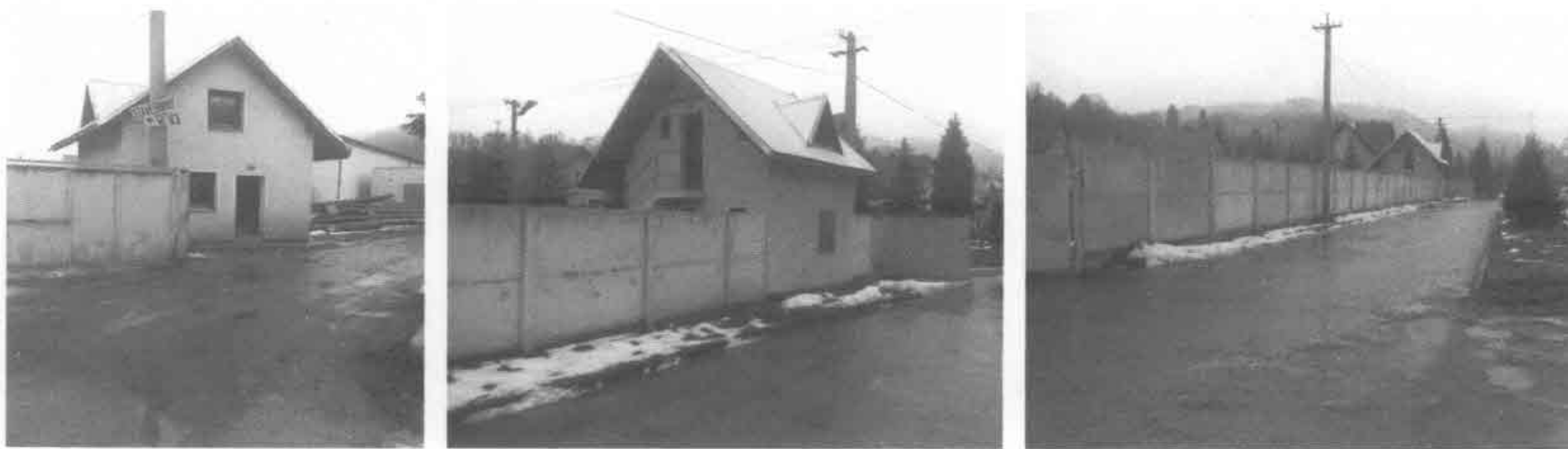
Vrátnica na parc. č. 1405/5 Vstup do areálu a prístupová cesta na parc. č. 1405/1
